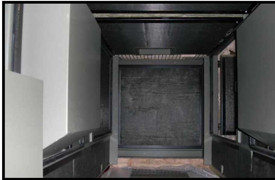
Imagen 5- Interior de un Grupo Electrónico insonorizado
